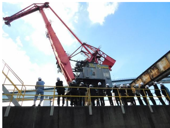
岸壁から材料を搬入するクレーン
