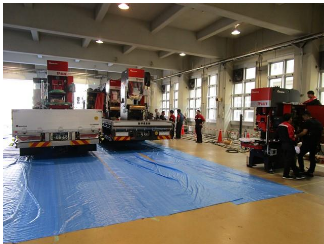
プレス機 6台の搬入、設置風景
