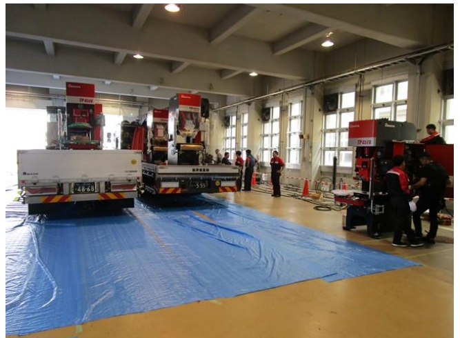
プレス機 6台の搬入、設置風景
